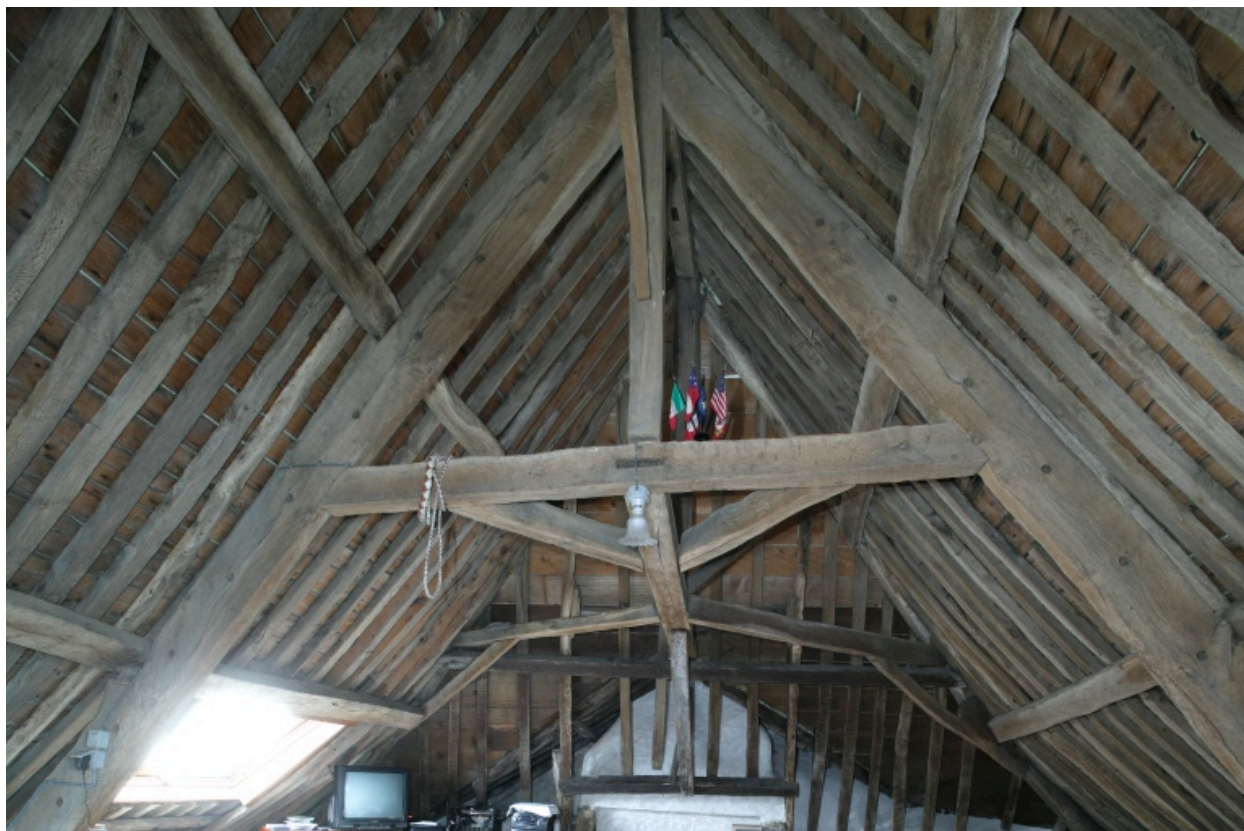
Charpente, vue vers l'Ouest.
