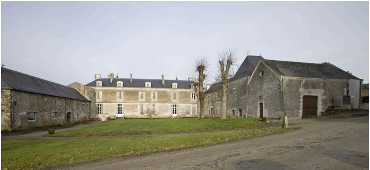
La cour : vue d'ensemble à partir de l'est.
