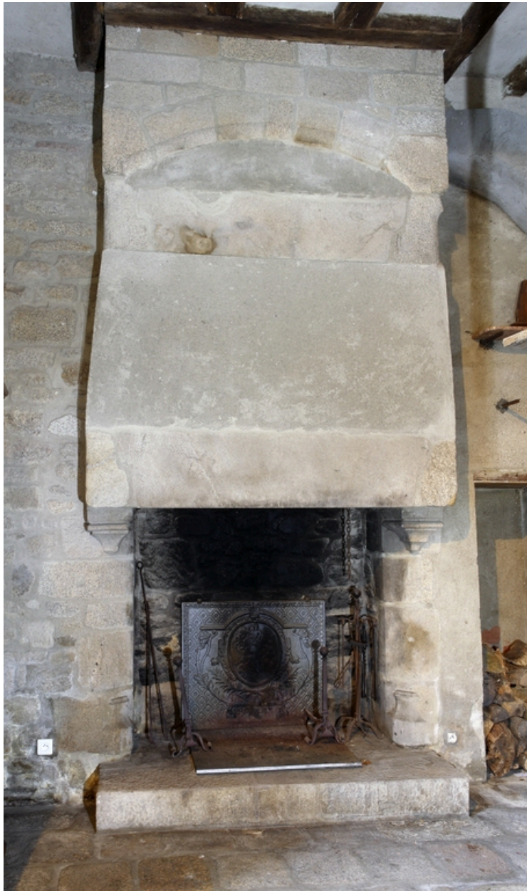
Logis. Aile nord. Rez-de-chaussée. Détail de la cheminée surbaissée.
