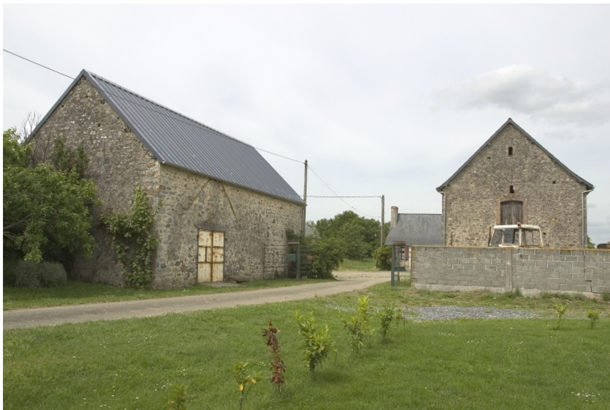
Vue d'ensemble depuis le sud : la remise, le logis, l'étable à vaches-grange.
