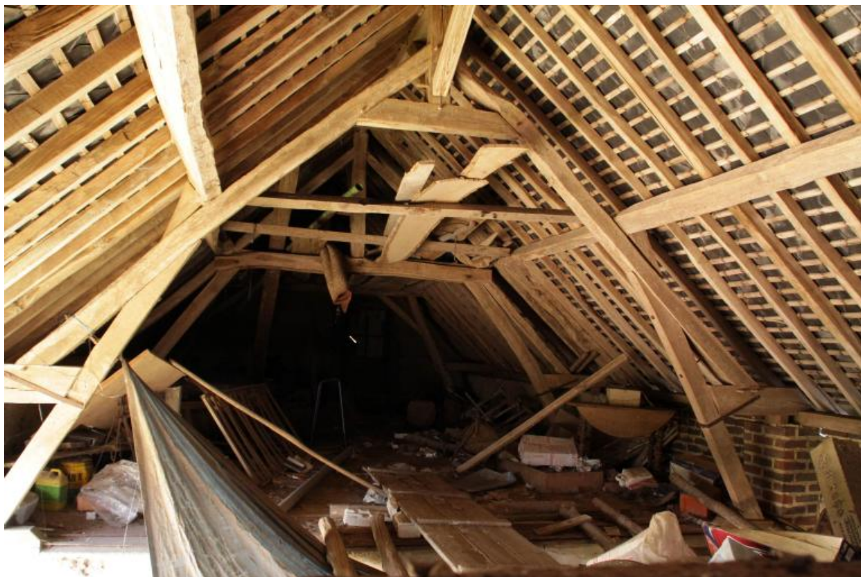
Grange : charpente sur potence.
