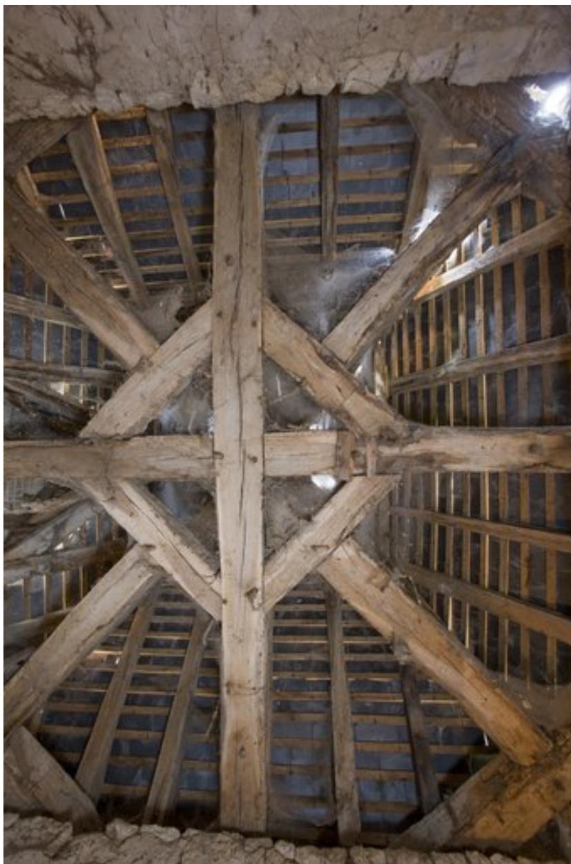
Vue de la charpente du pigeonnier.
