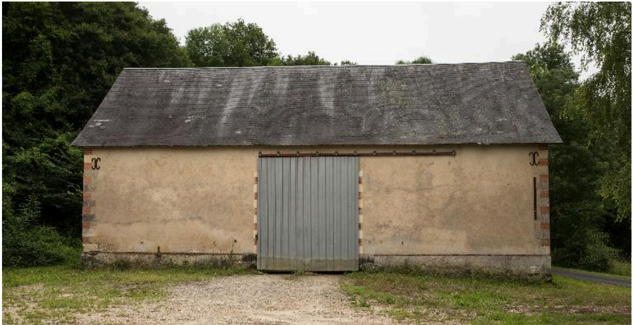
Grange, façade sur cour.
