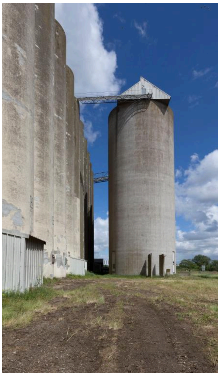
D : silos verticaux et passage entre les deux modules de silos.
