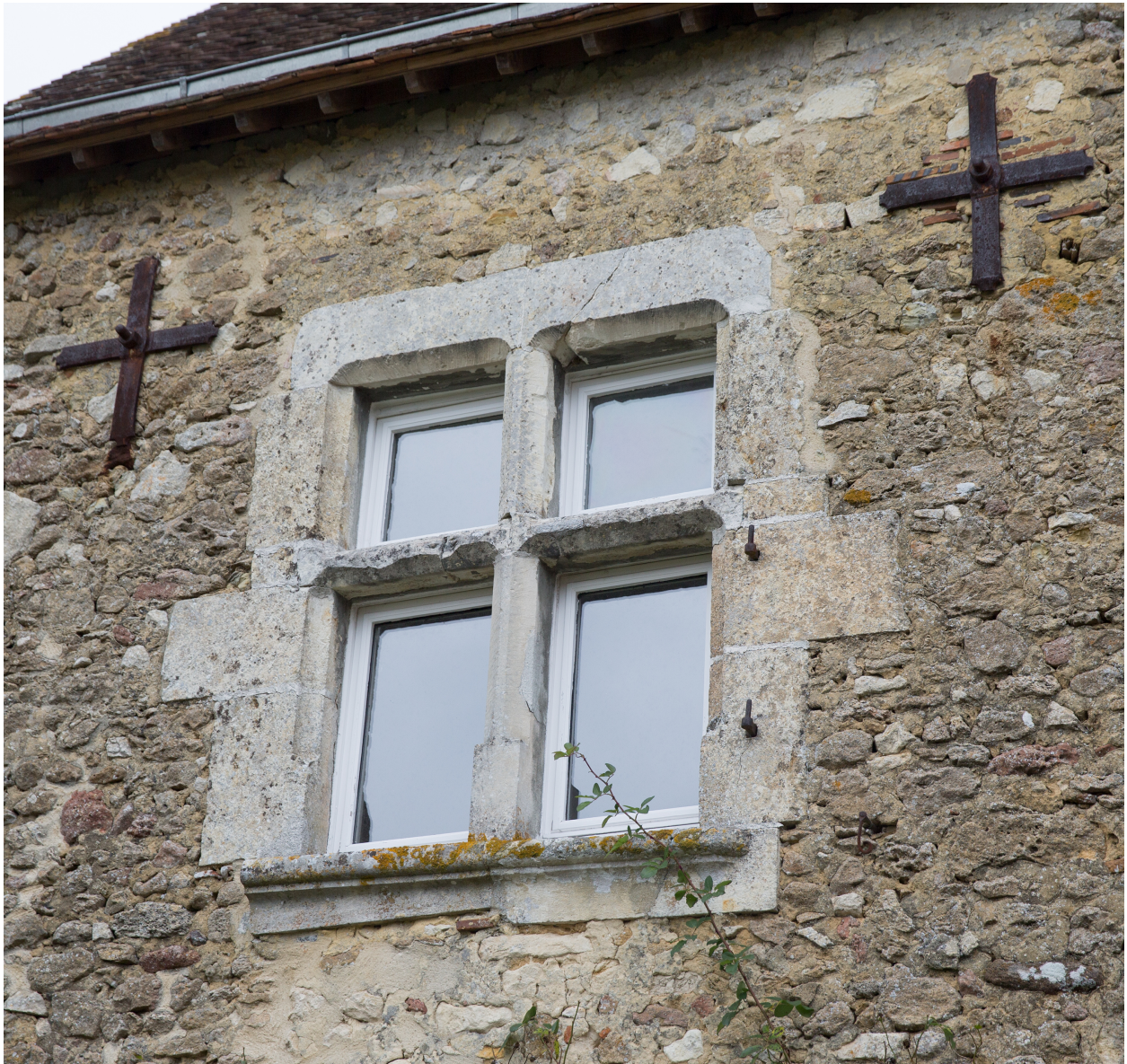
Une fenêtre à meneaux de l'étage.
