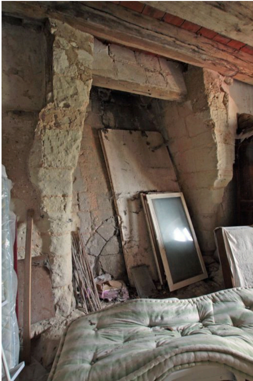
Le logis, 1er étage : cheminée sur le pignon sud.
