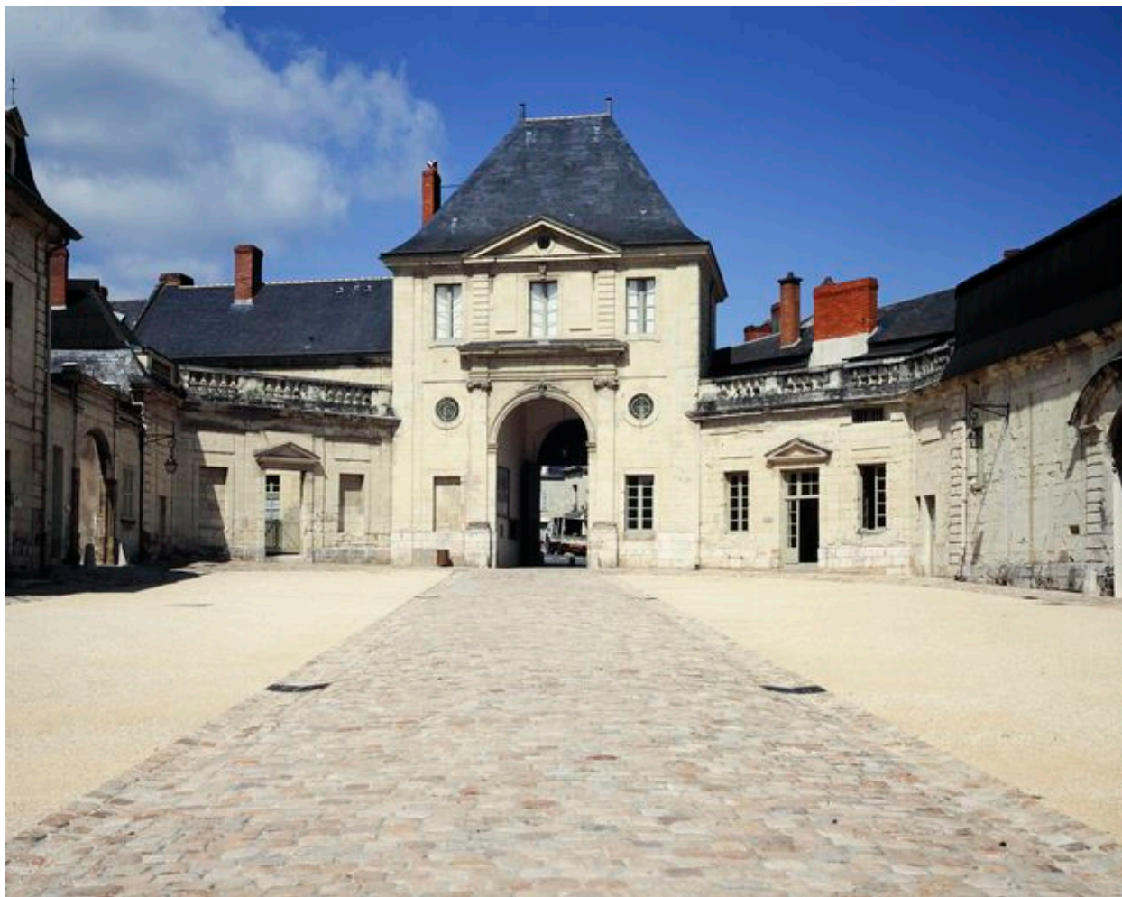
Grande porte de l'abbaye, façade intérieure.
