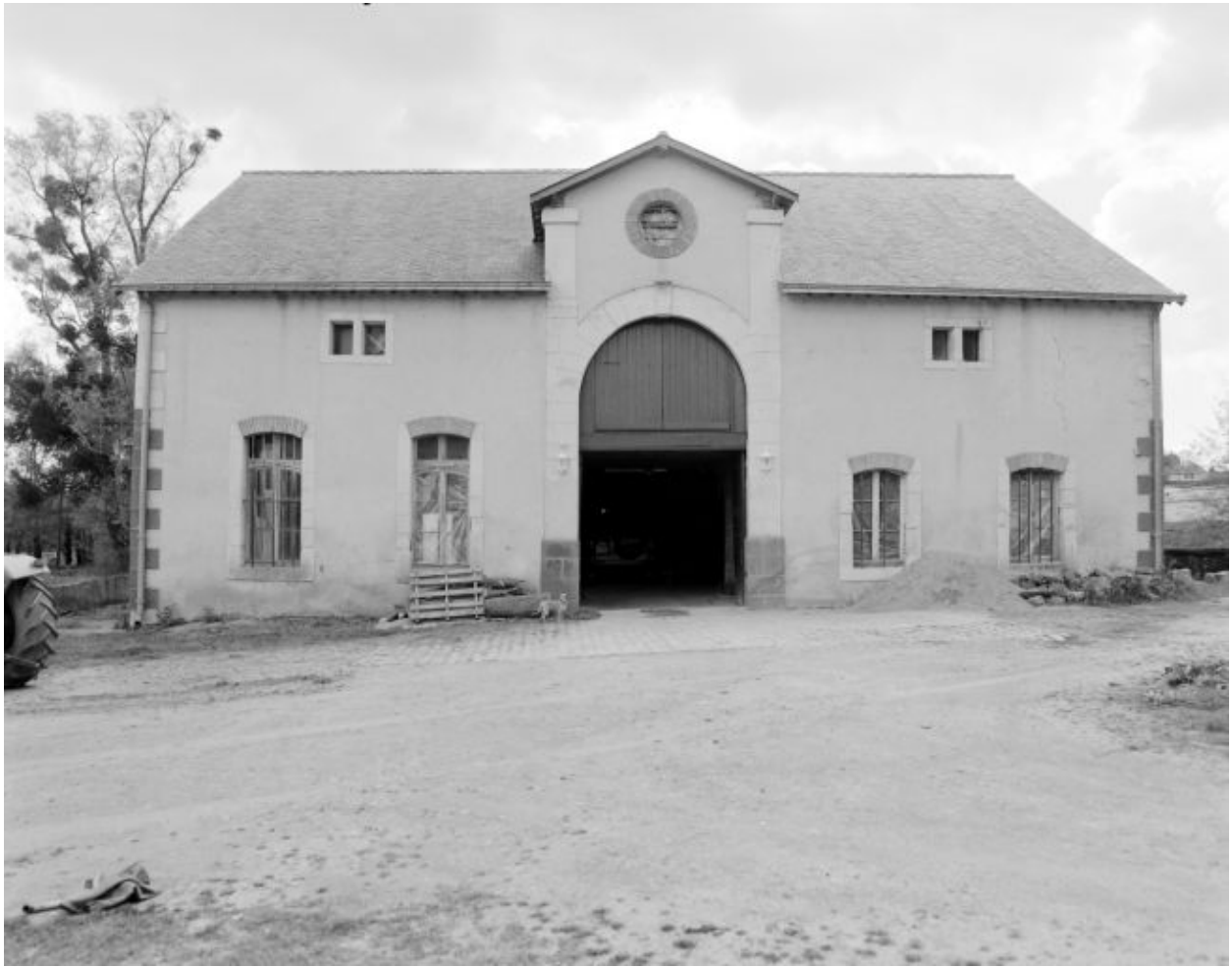
Le bâtiment qui abritait la remise et, à l'étage, un entrepôt. Vue du nord.
