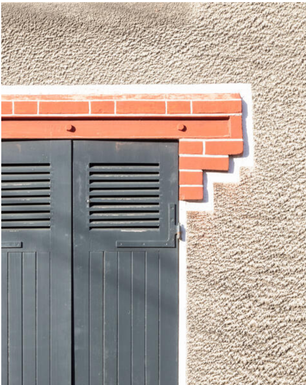
Détail d'un linteau métallique et encadrement de brique sur une fenêtre d'une maison de la collectivité.
