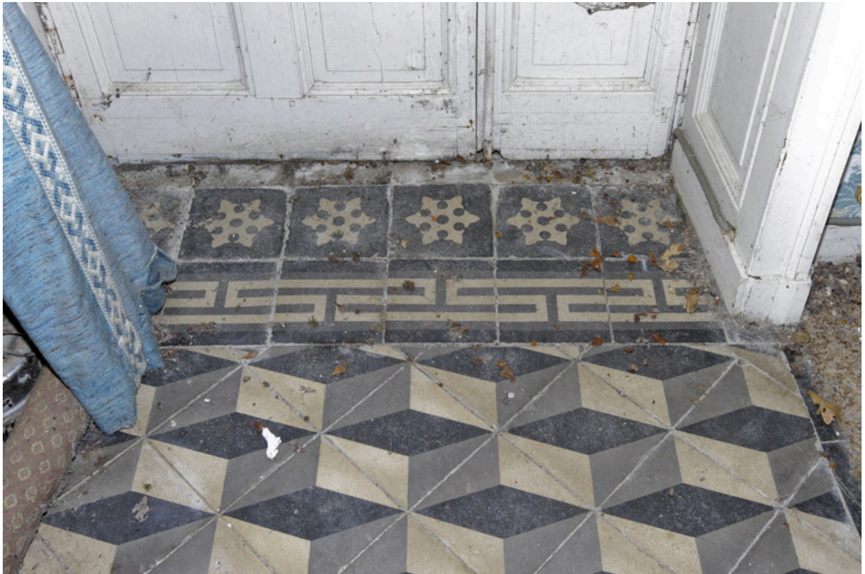
Logis. Vestibule d'entrée. Détail du carrelage.
