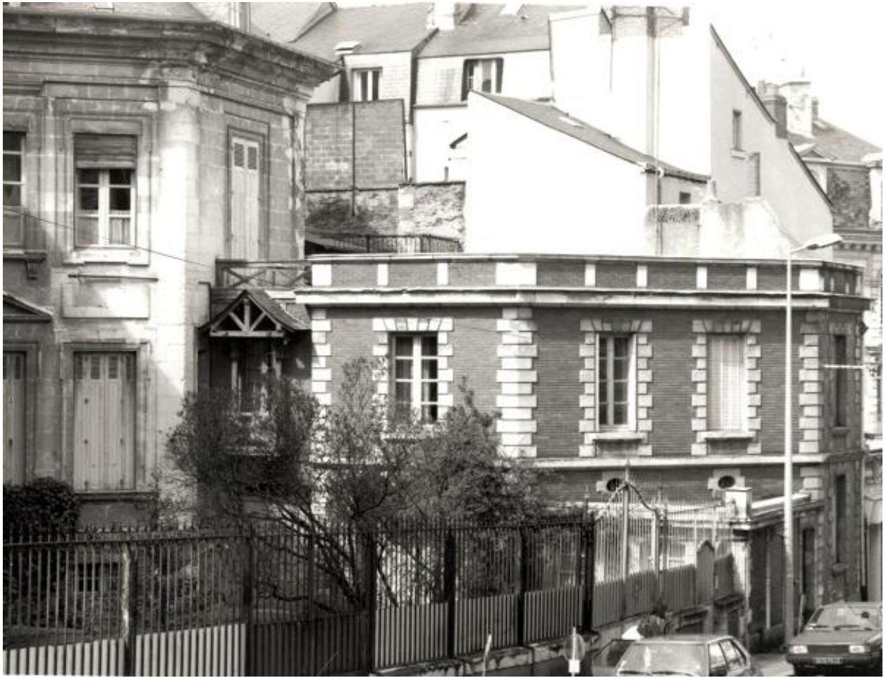
Corps de commons sur la cour antérieure : vue d'ensemble depuis la rue Emile-Bordier.
