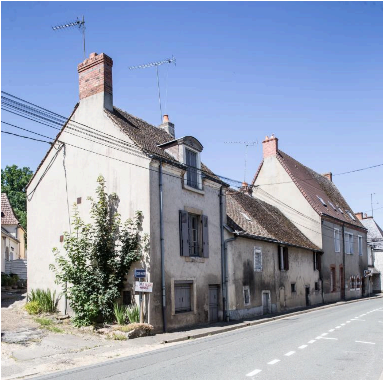
Des maisons entre la rue de la Gare et la cour Haute.
