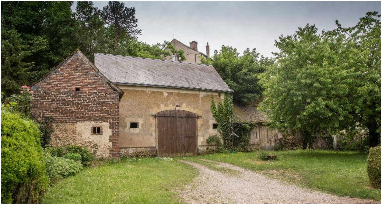
Dépendances agricoles du 5, rue de la Vallée du Bourgneuf.
