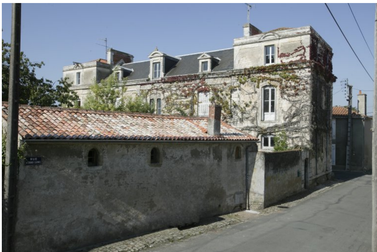
Vue d'ensemble prise du nord-est, montrant la façade sur jardin.
