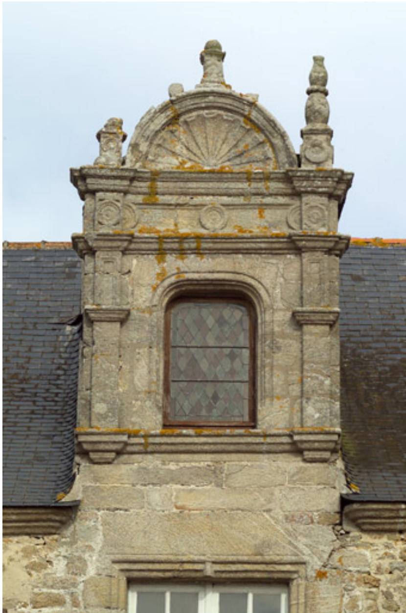
Lucarne de la travée à gauche sur l'élévation antérieure du logis.
