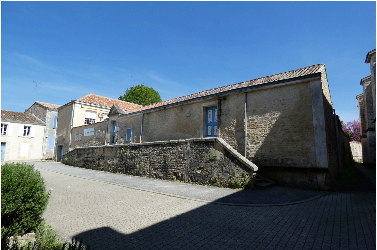
L'école vue depuis le sud-ouest.
