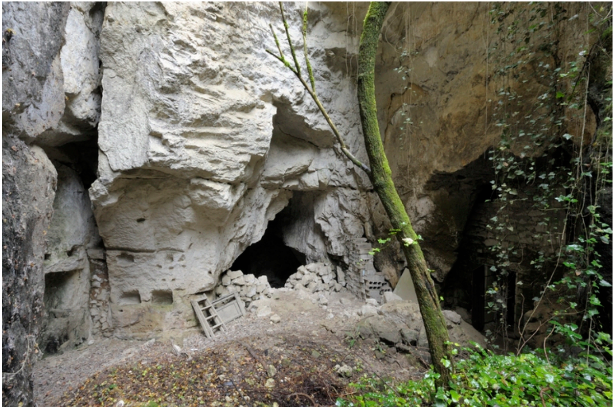
Fontis en partie postérieure de l'abri troglodytique. Vue générale.
