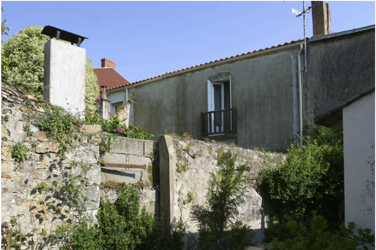
Façade postérieure de la maison n° 47 quai Chassagne.
