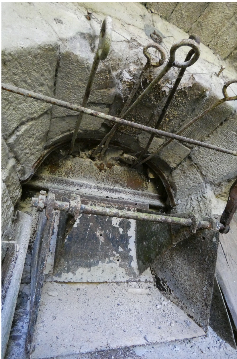
Trappe de défournement et son mécanisme.
