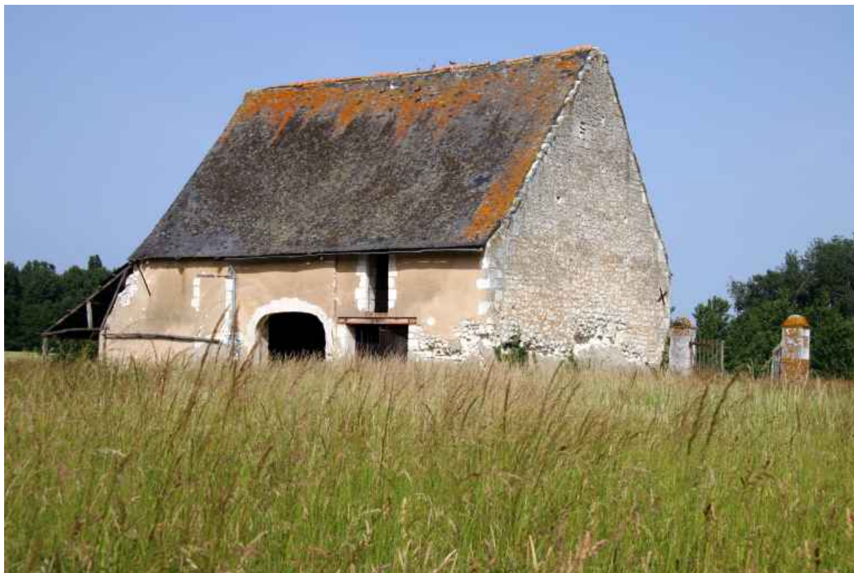
La grange : vue de volume.
