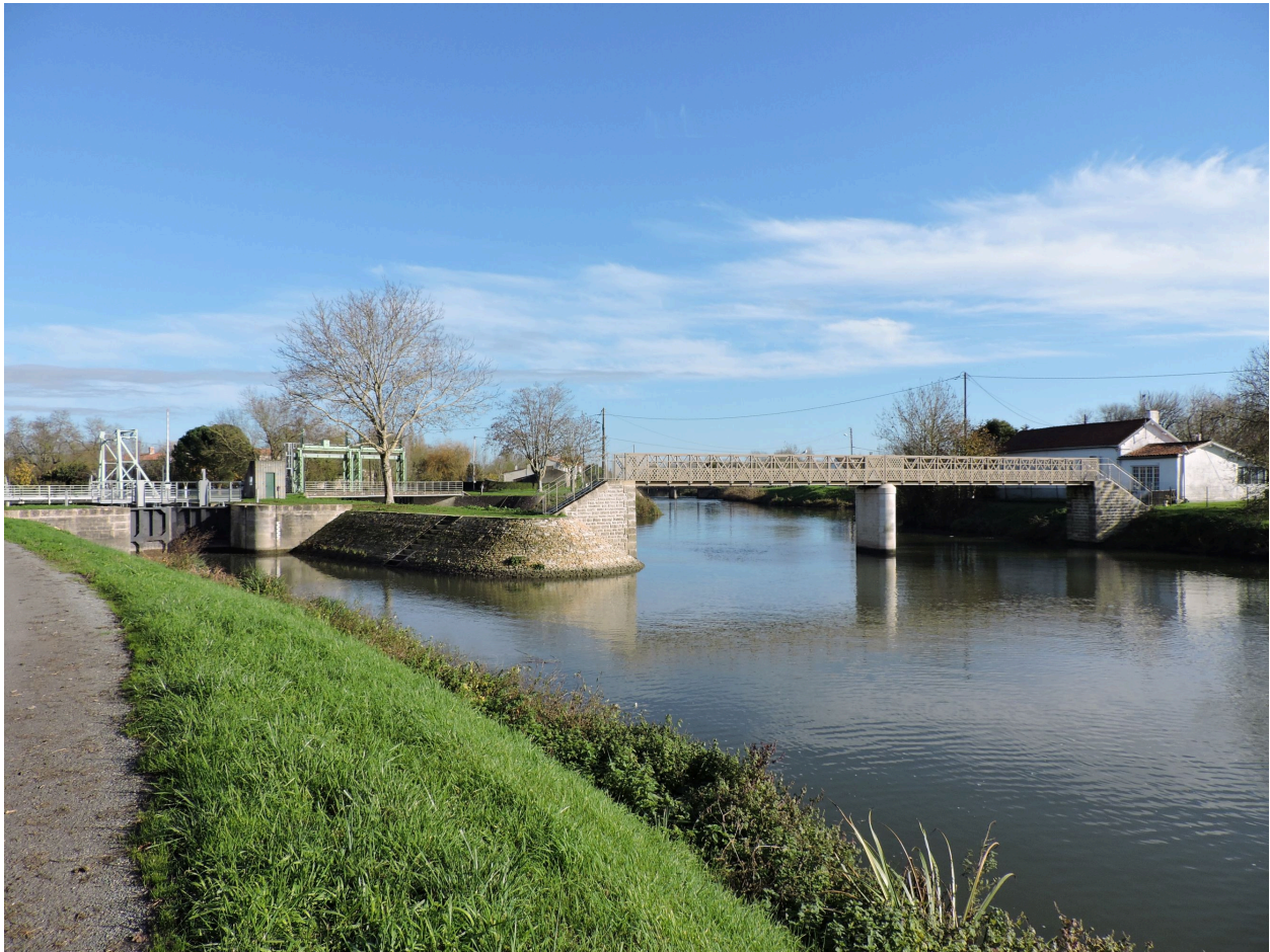
L'écluse et la passerelle sur la Sèvre Niortaise, vues depuis l'ouest, en aval.
