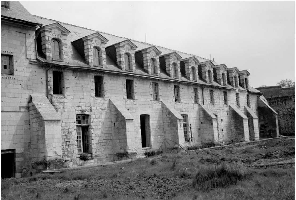
Prieuré Saint-Lazare, aile sud (vers 1960-1963, en cours de restauration) : barreaux arrachés.
