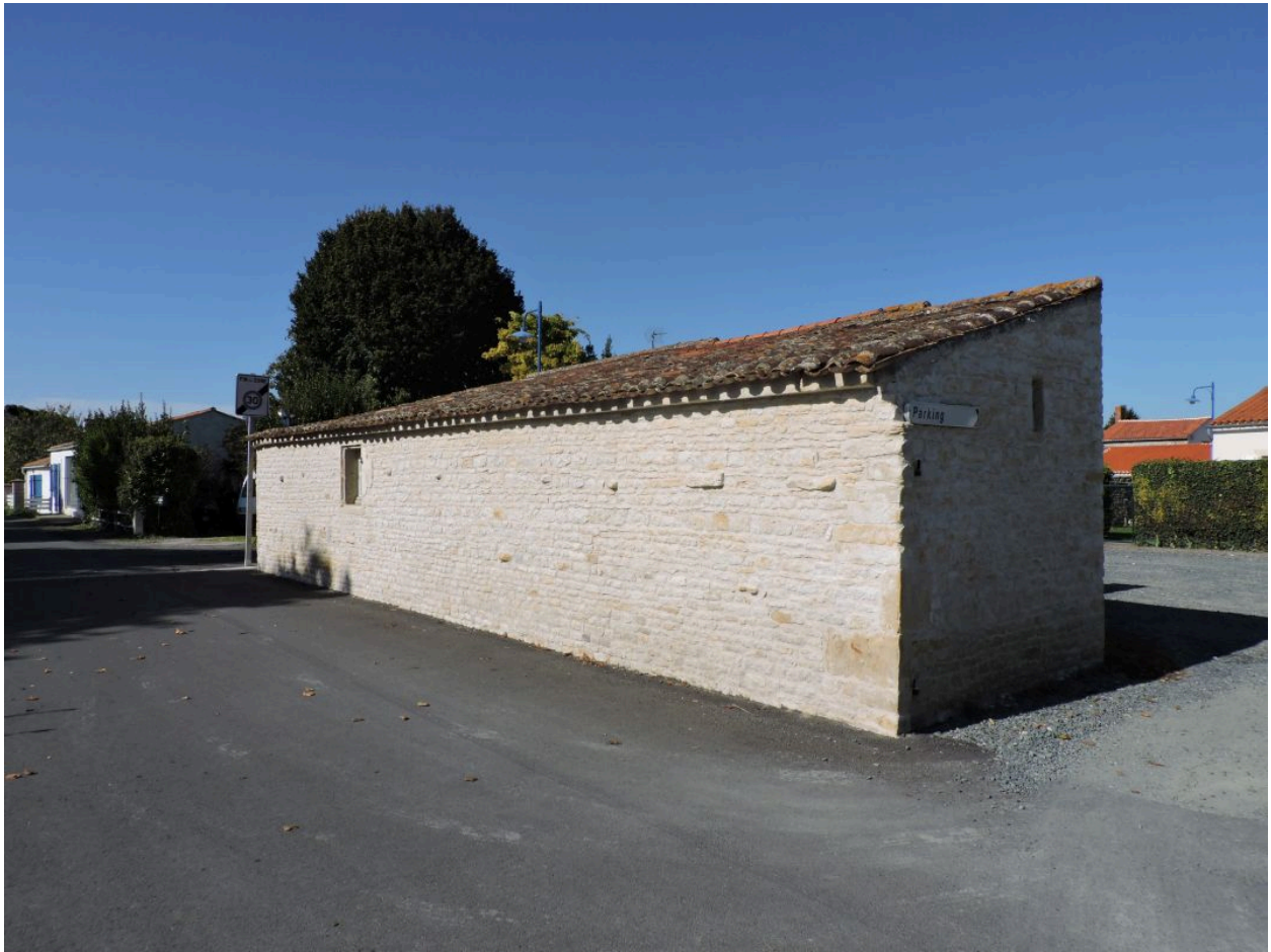
La remise à l'angle sud-ouest de la cour, vue depuis le sud-est.
