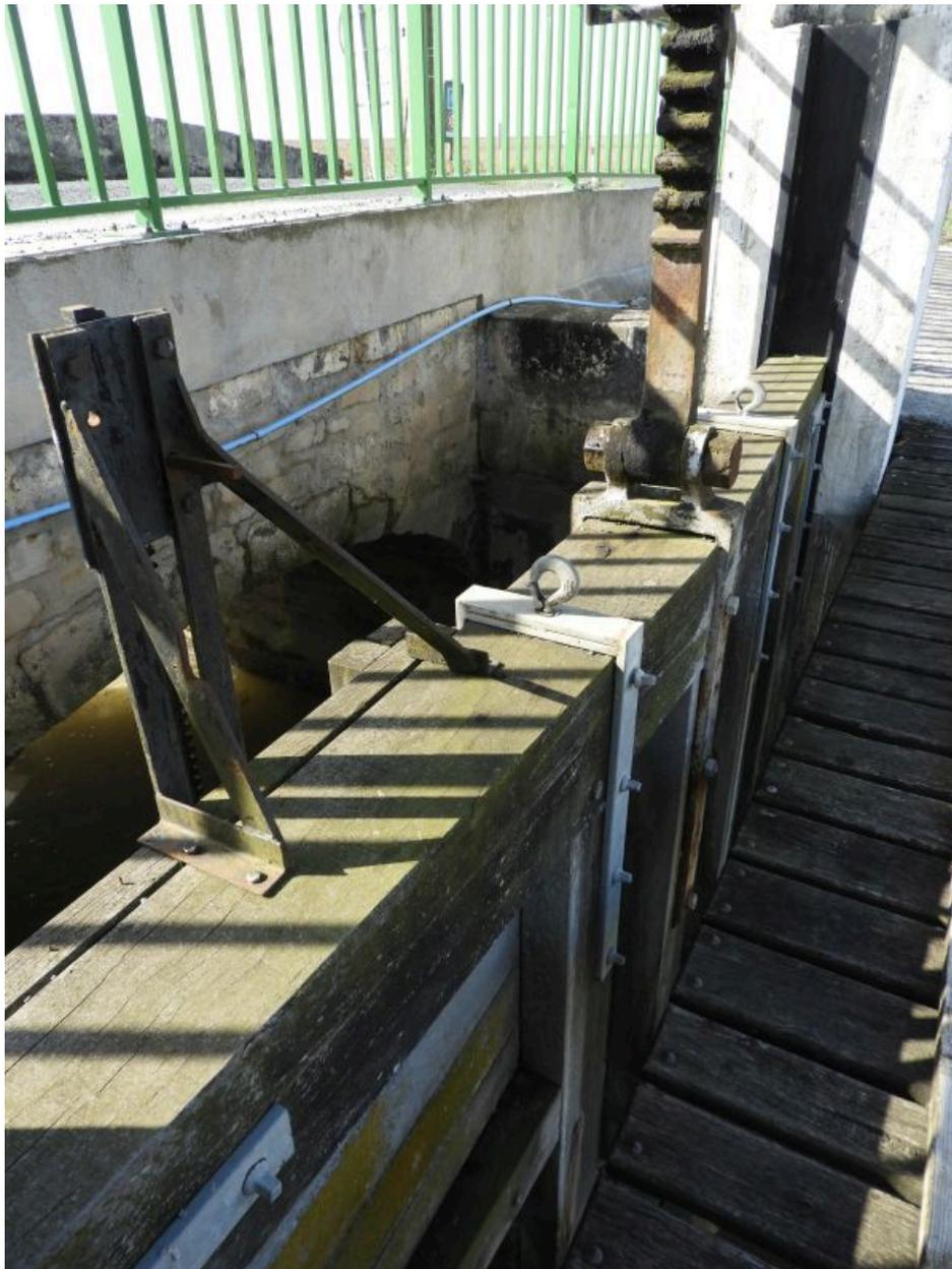
Détail de la vanne verticale : à gauche, le cric de la vantelle ; à droite, la fixation de la crémaillère.
