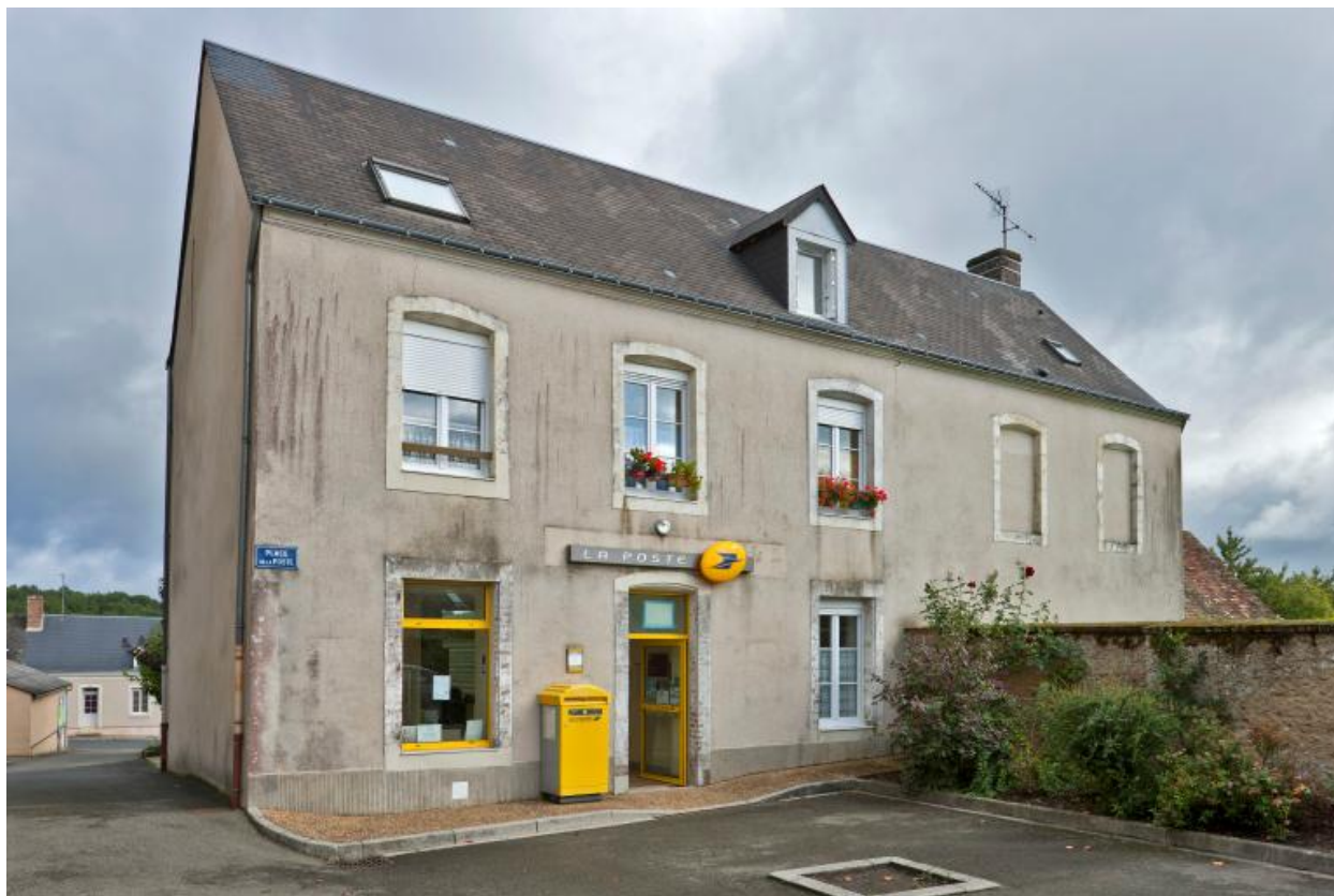
Ancien presbytère : vue de volume prise depuis le sud.
