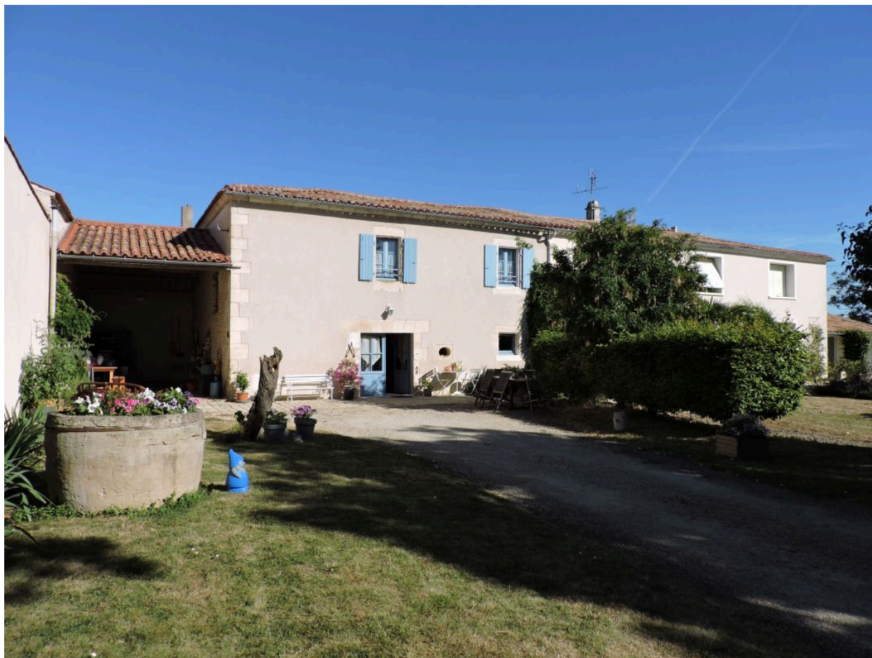
Partie nord vue depuis le sud-est : logis remanié à droite, hangar et grange-étable à gauche.
