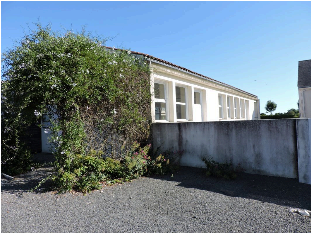
L'ancienne cantine, à l'est de l'ensemble, vue depuis le nord.
