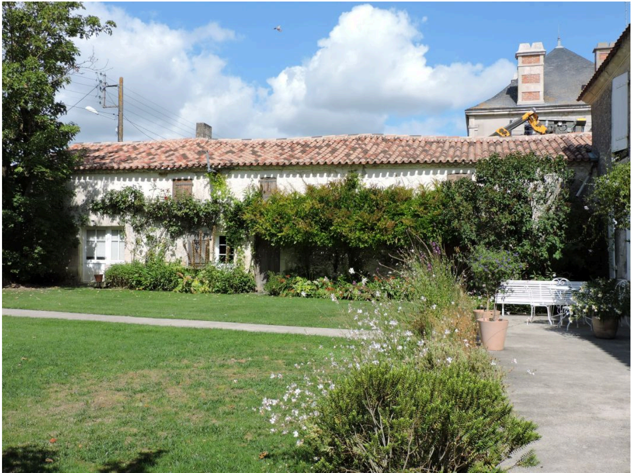
L'aile ouest, ancien logement et communs, vue depuis le sud-est.
