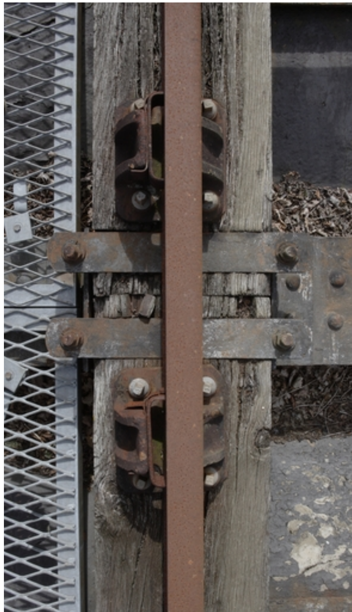
Détail des fixations des rails.
