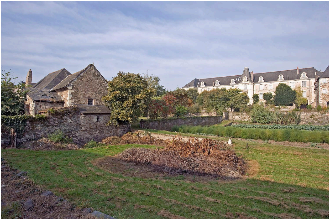
Le bâtiment du pensionnat, vue depuis la ferme.
