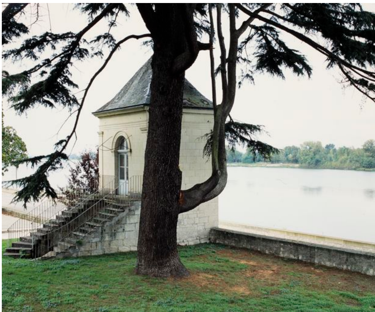
Pavillon : vue d'ensemble avant restauration.
