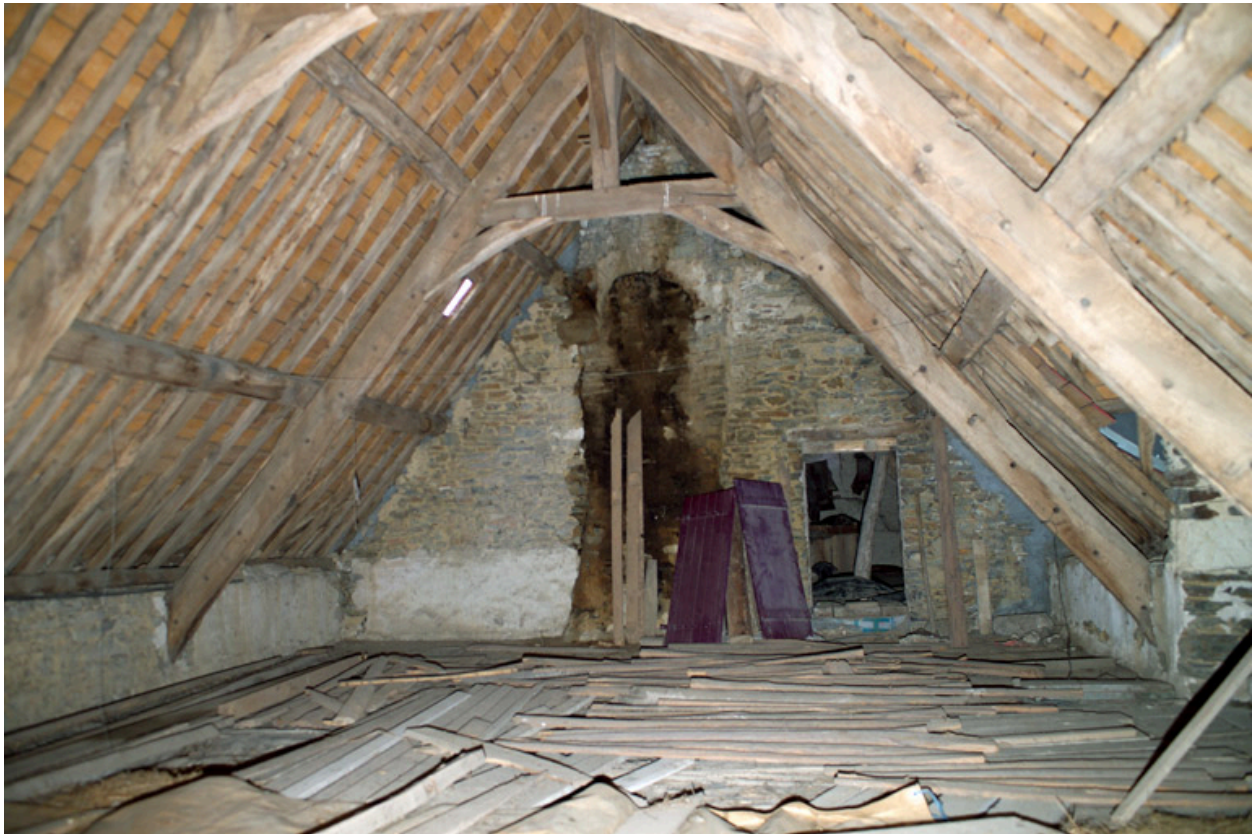
Charpente de l'avant-dernier logement à l'est.
