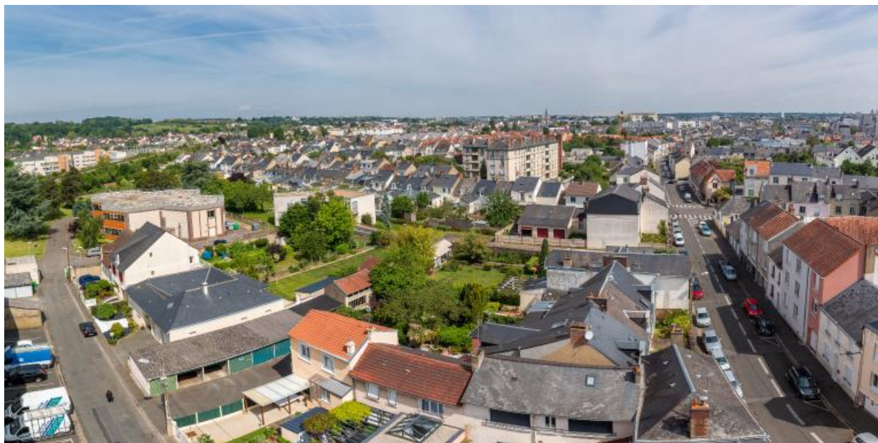
Vue de Saint-Pavin depuis l'immeuble du Pâtis.
