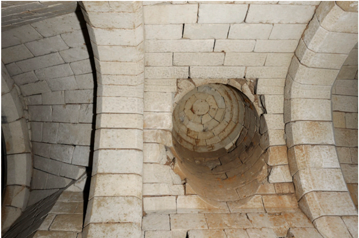
Voûte du palier du second sous-sol : détail du conduit circulaire, obturé.
