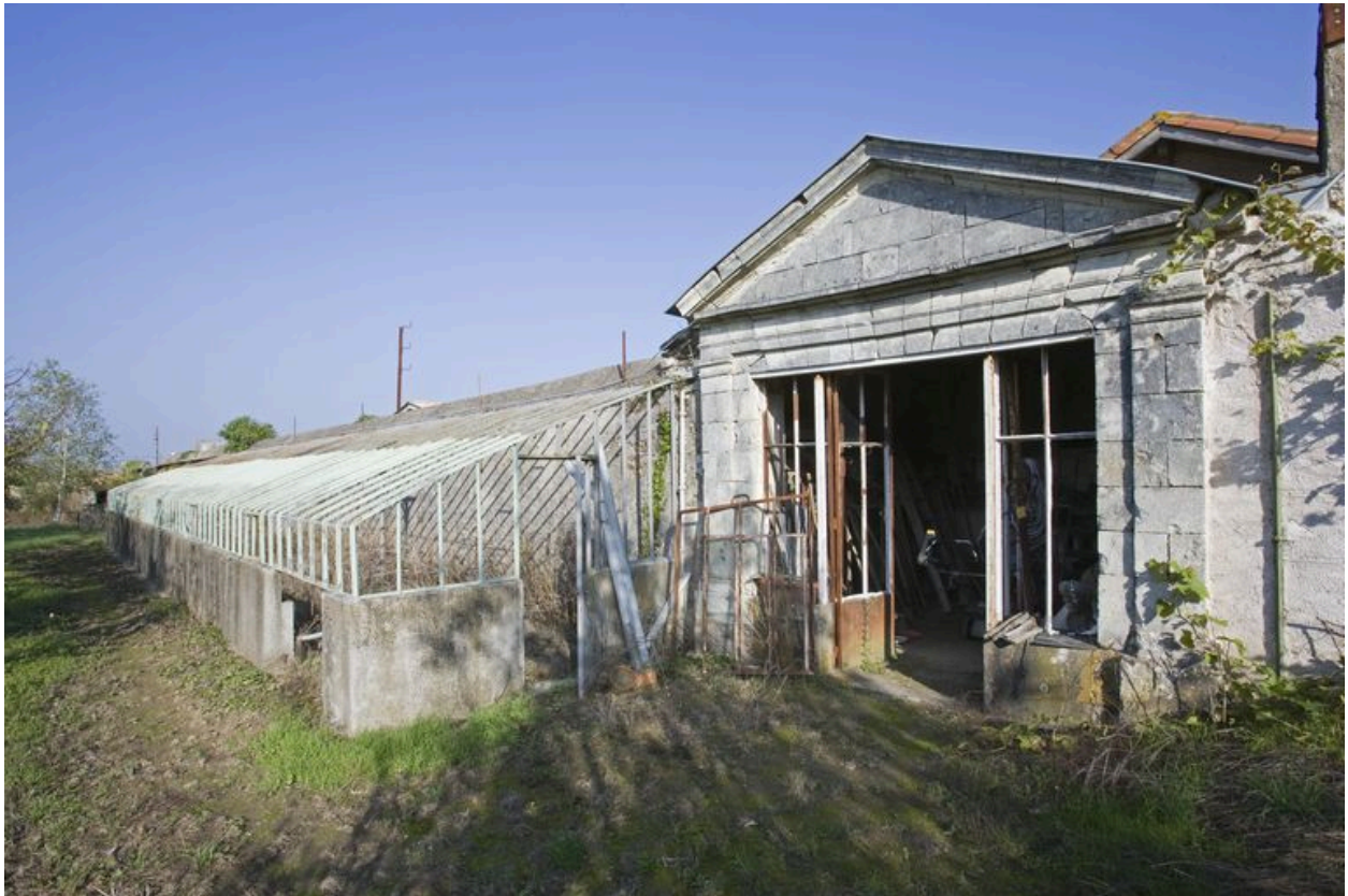
Jardin. L'orangerie, à la façade incluse dans le mur de clôture (ca 1800) ; la serre adossée (ca 1935).
