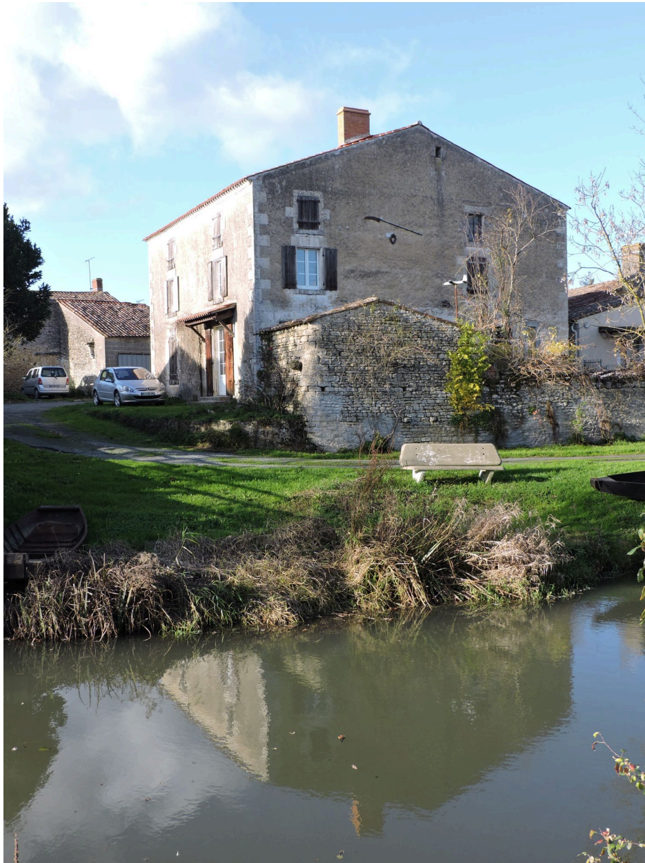
La maison vue depuis le sud-est.
