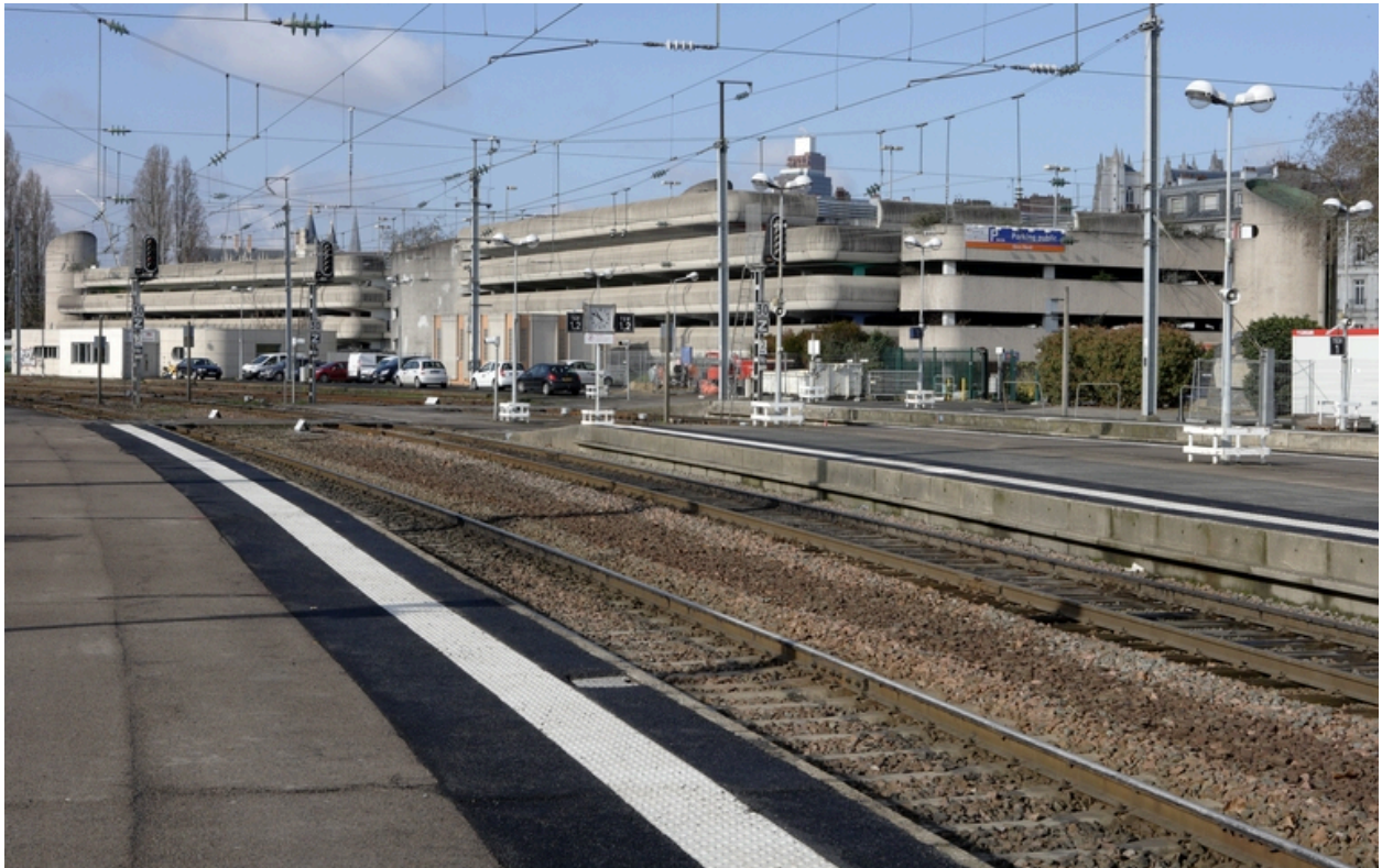
Parking, accès nord.
