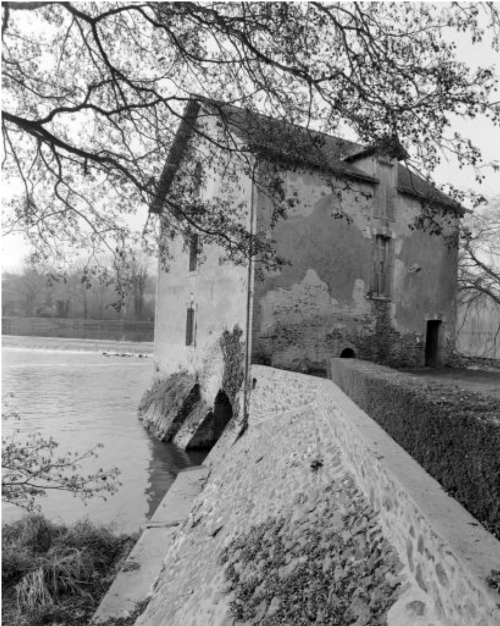
Vue de l'est : façades sud-est (d'aval) et nord-est.
