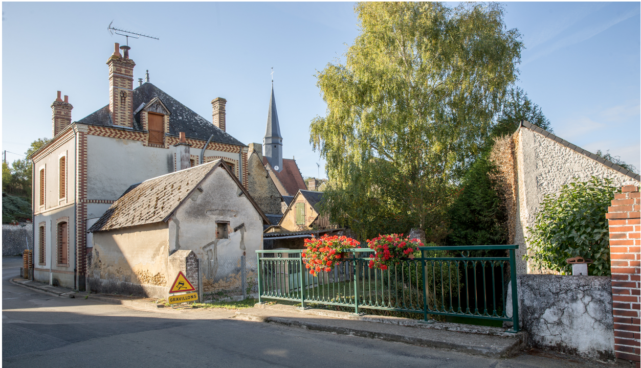
Le pont (reconstruit) sur le Boutry, rue de l'Eglise sur le Boutry.
