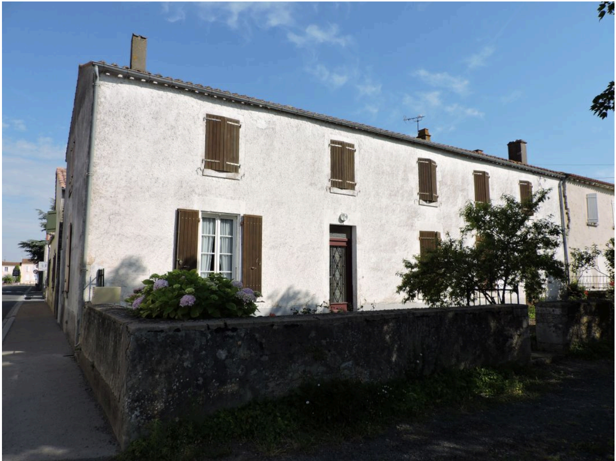
Le logis vu depuis le sud.
