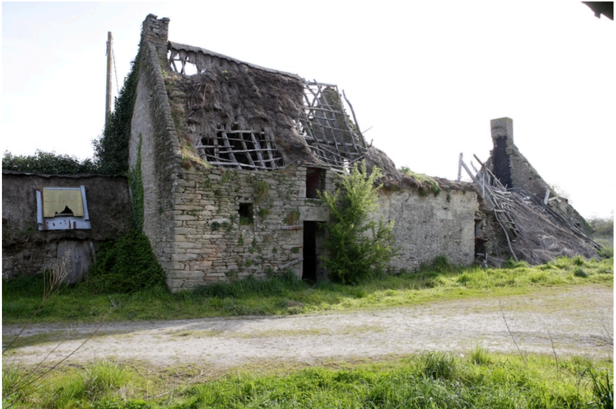
Vue de l'ancien logis depuis l'ouest.
