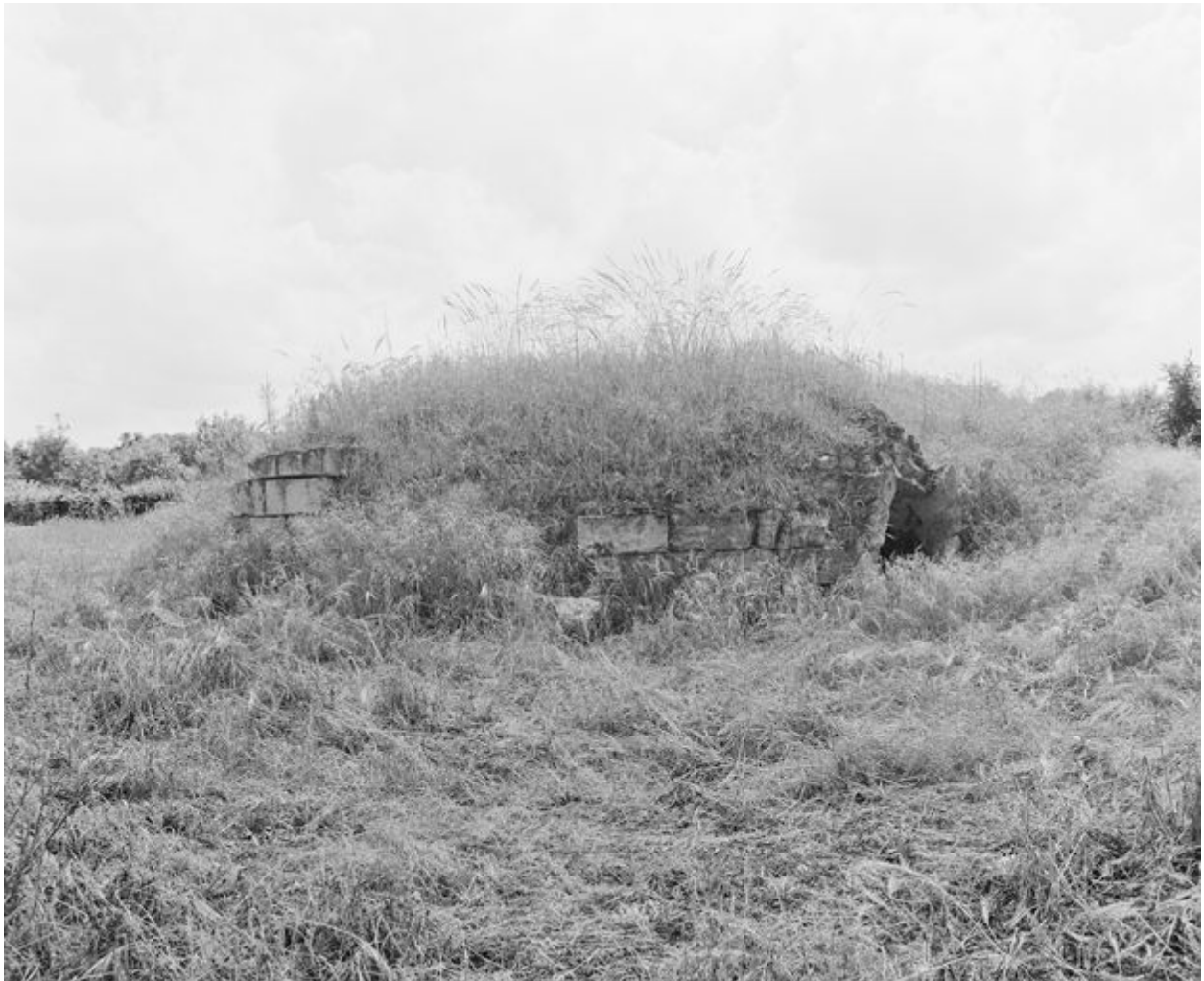
Vestiges de la chapelle Notre-Dame-de-Liesse : ruines de la chapelle, dans le Clos Bourbon, assises basses du chevet vues depuis l'est (vue prise en 1996).
