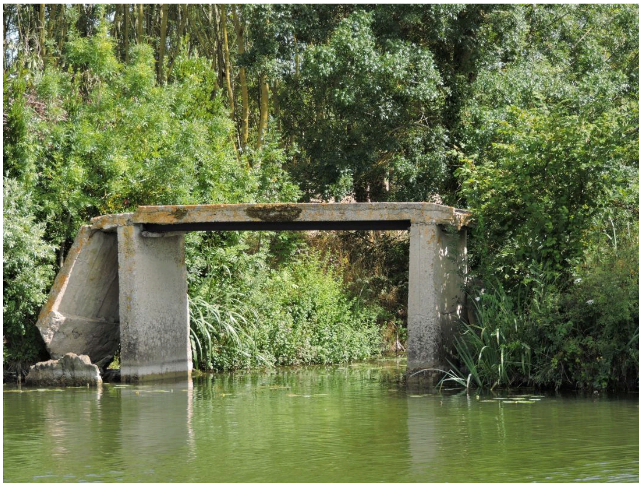
La passerelle vue depuis le nord.
