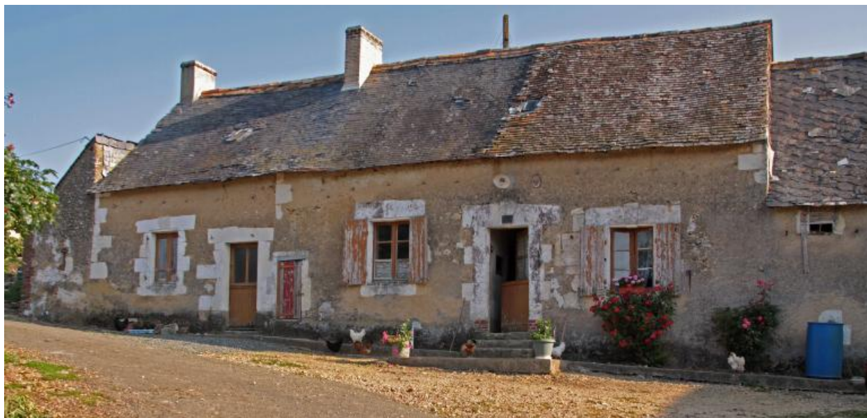
Maisons 1 et 2 : façades sur cour.
