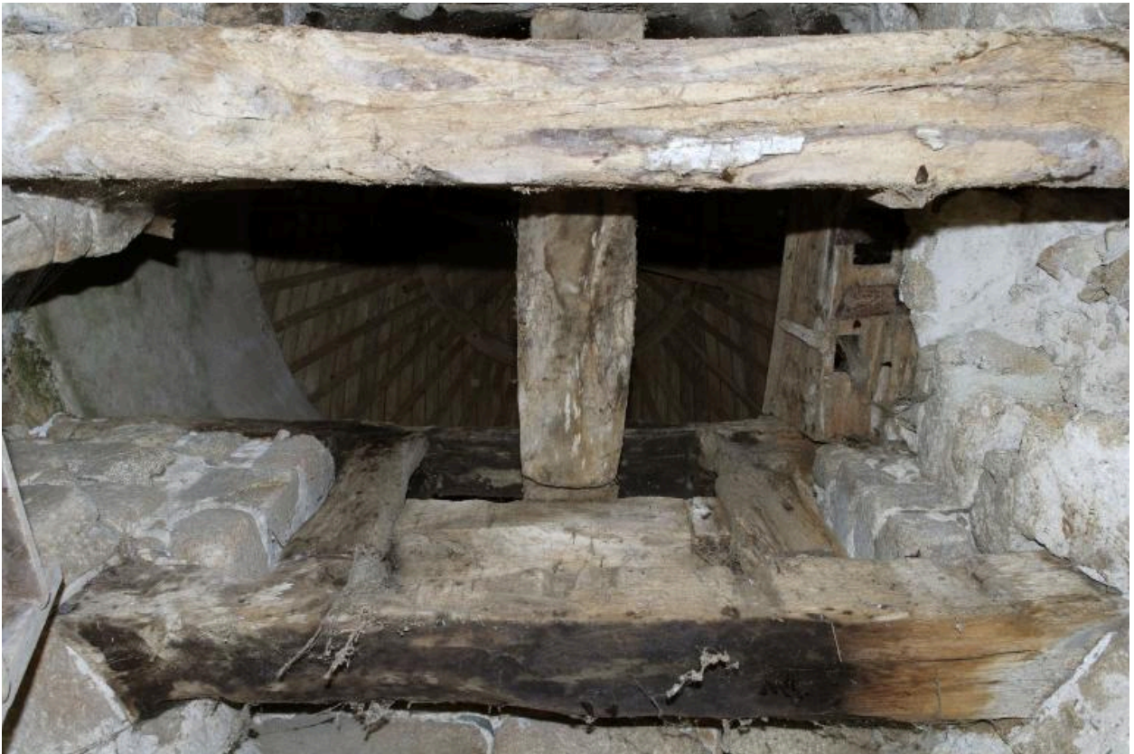
Intérieur. Charpente de la trempure, détail du cadre sud, avec le palier et son levier. Vue de bas en haut.
