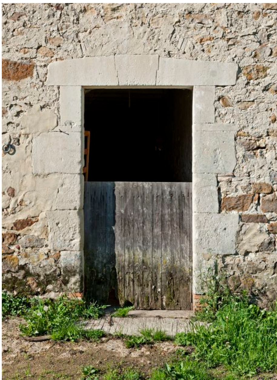
Porte droite des étables de la grange-étables-fenil.
